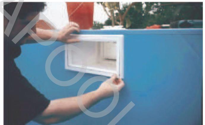
Eine Dichtung kommt hinter die Folie (direkt auf das Einbauteil), die zweite Dichtung kommt vor die Folie. Danach wird der Flansch durch die Folie hindurch angeschraubt. Erst dann wird die Folie ausgeschnitten. Das Anschrauben darf nur von Hand geschehen, um die Schrauben nicht abzdrehen.
